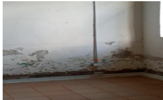
SE REALIZO LA ACTIVIDAD DE COLOCACION DE SALIDA + TOMACORRIENTE EN LAS AULAS # 3 Y #4 .
