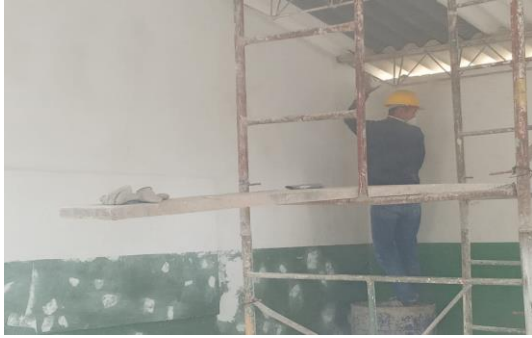
SE REALIZO LA ACTIVIDAD DE PAÑETE, APLICACIÓN ESTUCO Y PINTURA VINILO TIPO 1 EN LA AULA # 5
