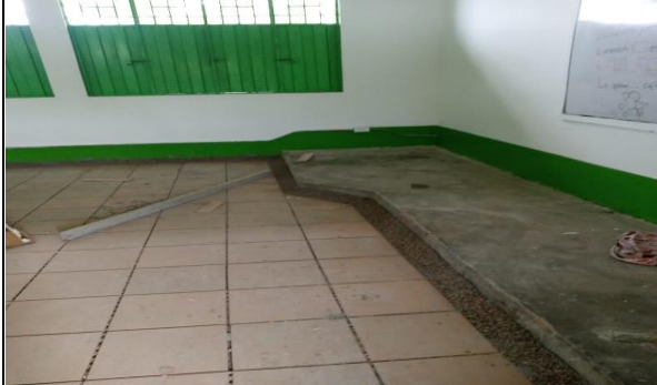
SE REALIZO LA ACTIVIDAD DE APLICACIÓN PINTURA VINILO TIPO 1 Y MEDIA CAÑA EN GRAVILLA LAVADA
