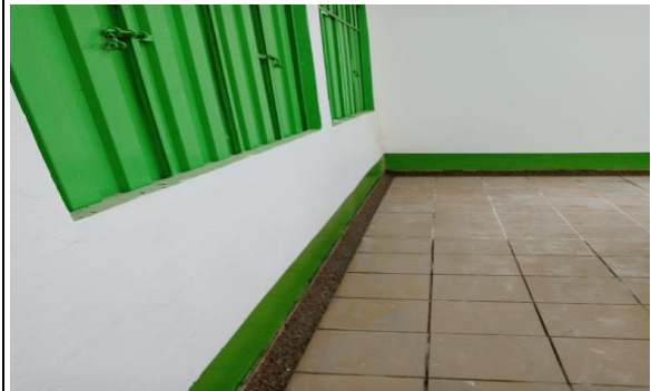
SE REALIZO LA ACTIVIDAD DE APLICACIÓN PINTURA VINILO TIPO 1 Y MEDIA CAÑA EN GRAVILLA LAVADA
