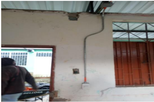
SE REALIZO LA ACTIVIDAD DE COLOCACION DE INTERRUPTOR EN LAS AULAS # 3 Y #4 .
