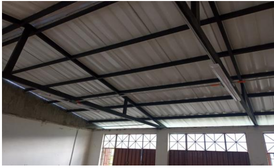
SE REALIZO LA ACTIVIDAD DE COLOCACION TUBERIA EMT DE 1/2" Y LUMINARIA 2X18 W'.
