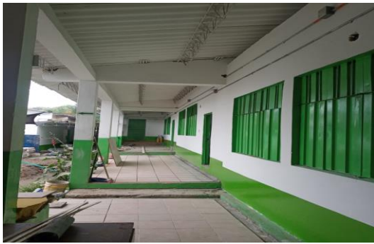
SE REALIZO LA ACTIVIDAD DE APLICACIÓN PINTURA VINILO TIPO 1
